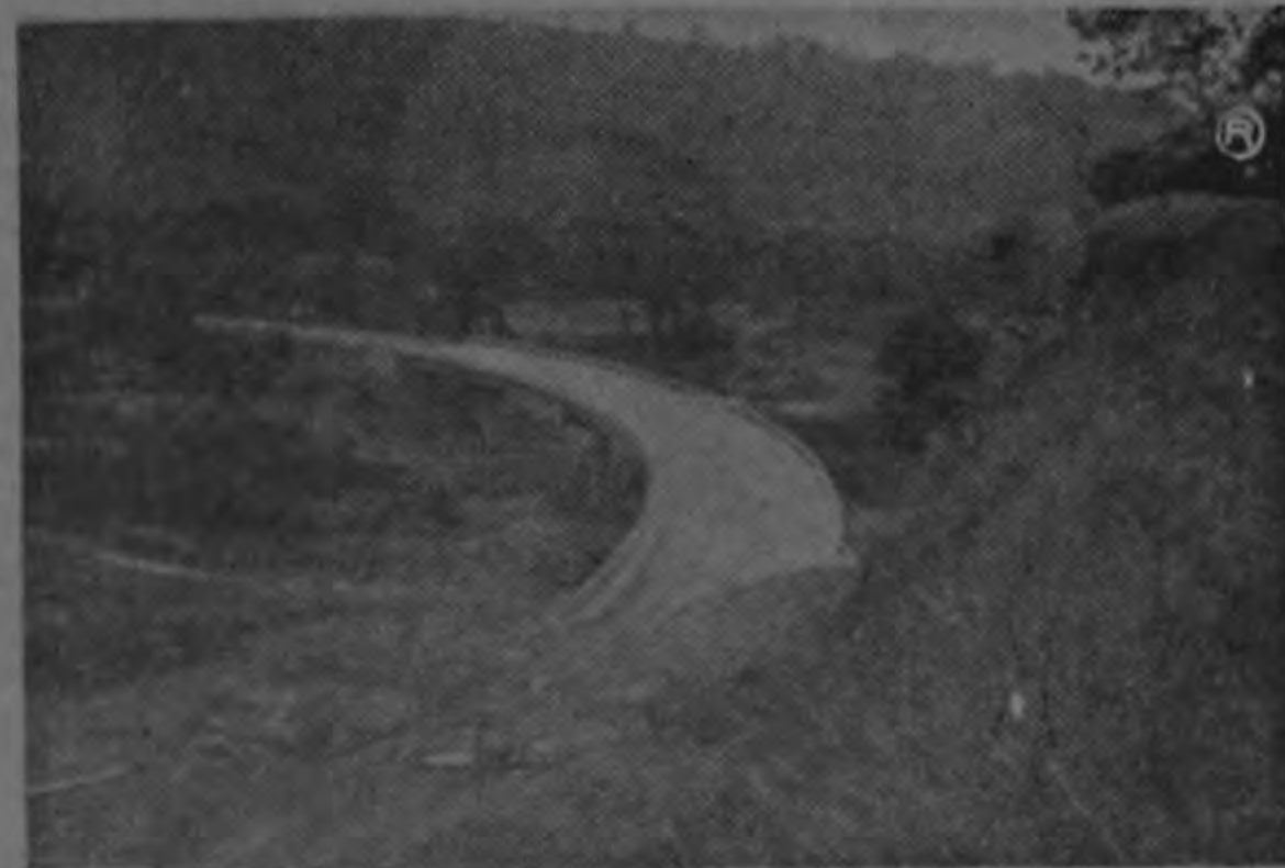
Este es el puente sobre el río Ceibo, construido en la Carretera Interamericana sección del sur, entre San Isidro del General y la frontera con Panamá. Consta de cinco tramos y es una notable obra de ingeniería, desde el punto de la técnica empleada en su estructura de curva.
